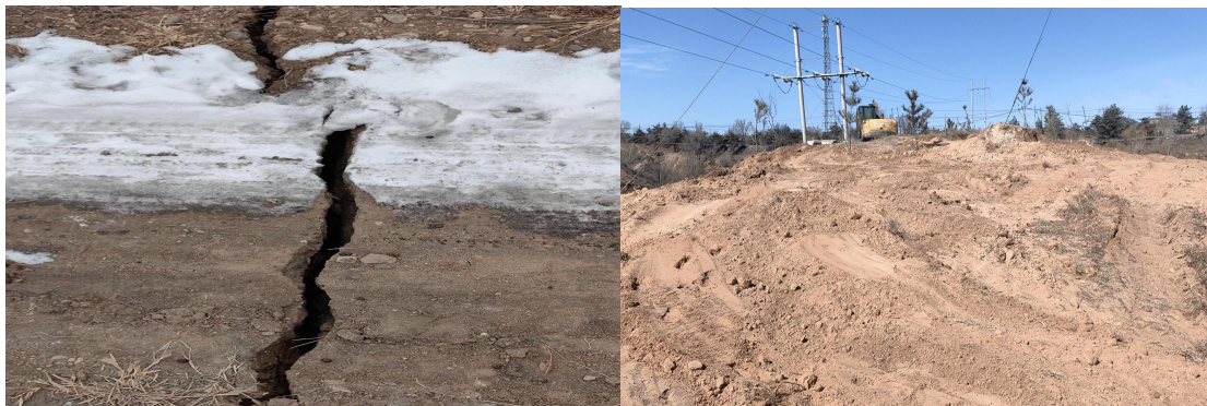
照片4-13 2024年度31110综采工作面裂缝回填前后照片3
