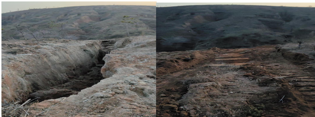
照片4-11 2024年度31110综采工作面裂缝回填前后照片1
